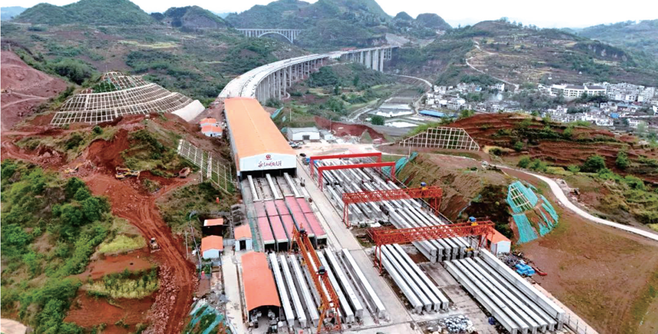
山区智慧梁场存梁区及蒸养区。
