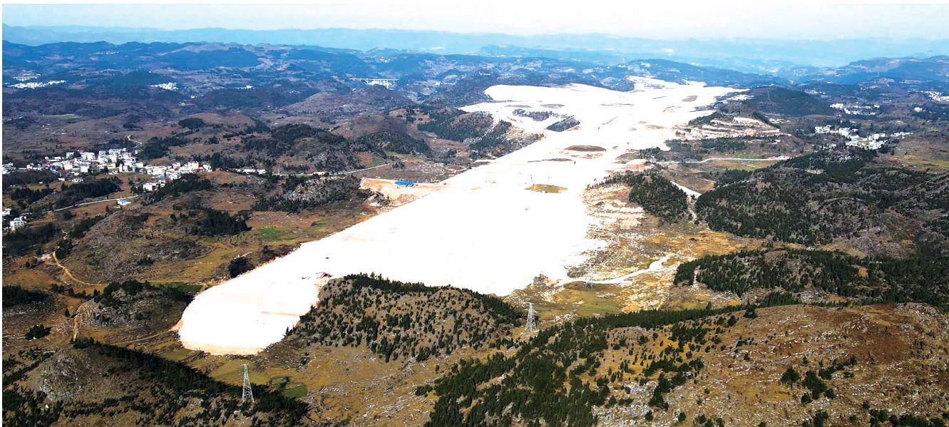
建设中的官山机场。
