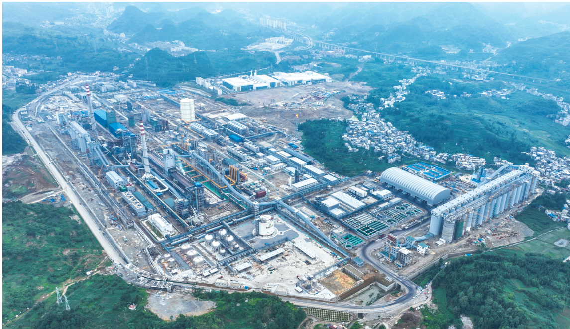
贵州美锦华宇“煤—焦—氢”综合利用示范项目。(资料图)
