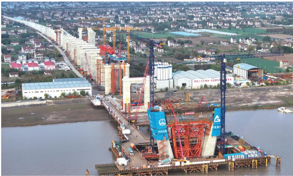
崇启公铁长江大桥进入主塔下横梁浇筑阶段
