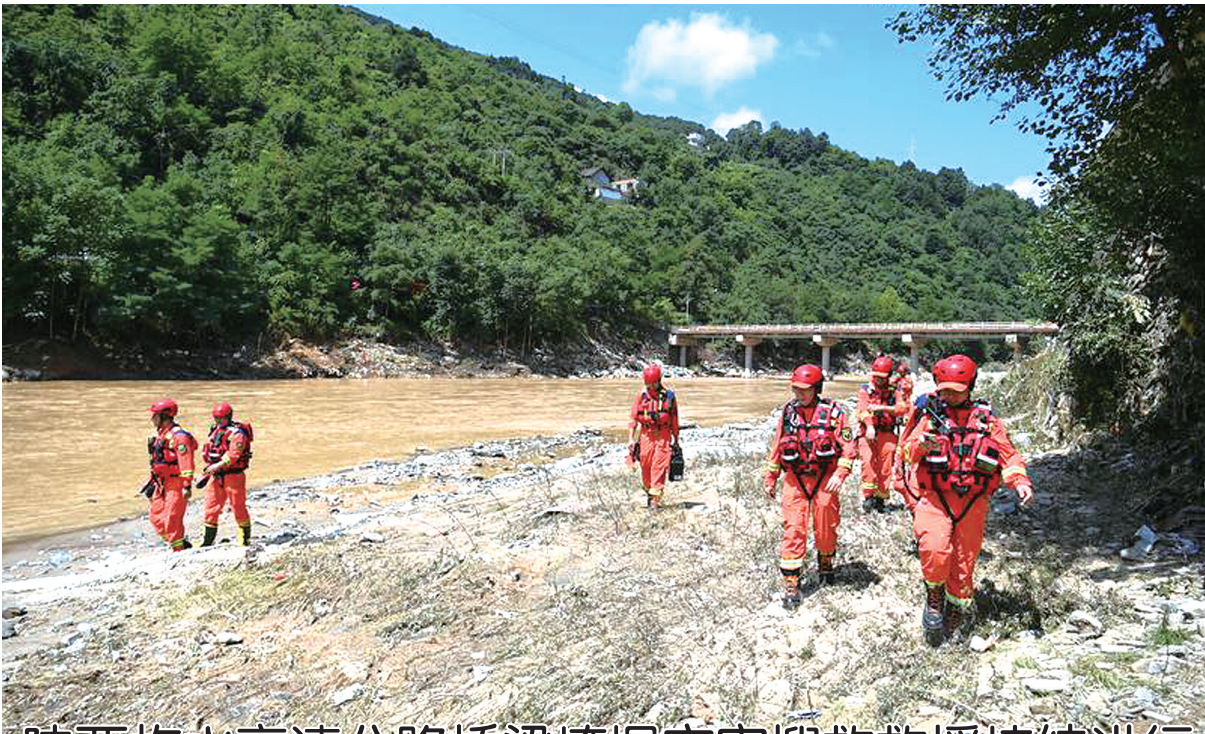
陕西柞水高速公路桥梁垮塌灾害搜救救援持续进行
