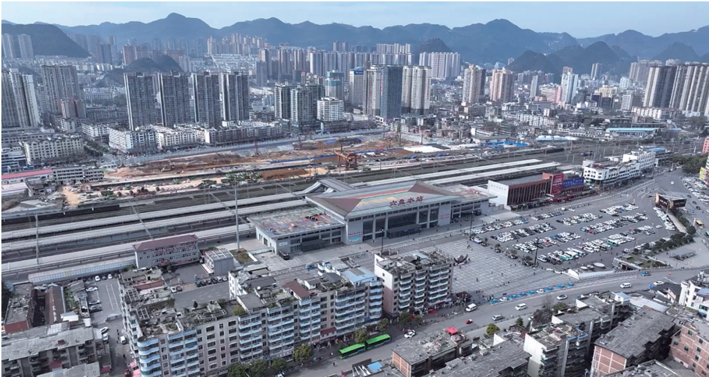
2023年3月20日,安六高铁六盘水站站前广场项目建设快马加鞭。
